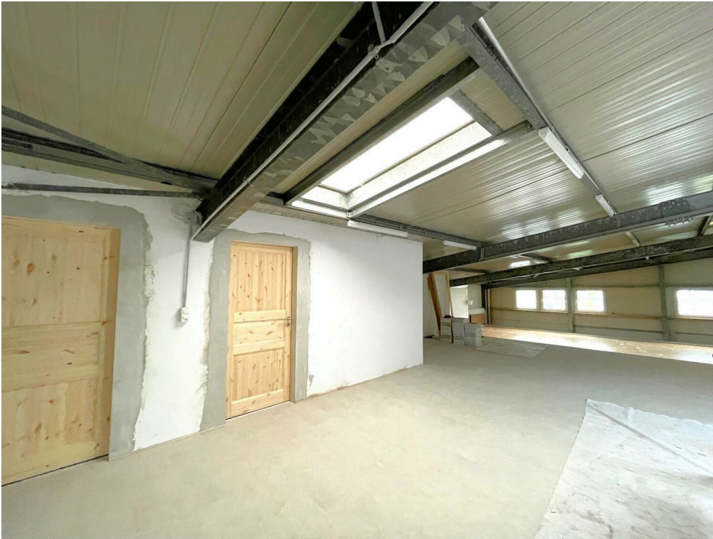
étage - accès wc
