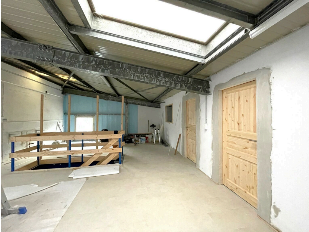
étage nord - espace cafeteria
