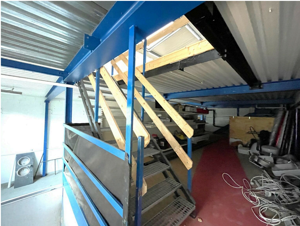
accès à l'étage avec mezzanine
